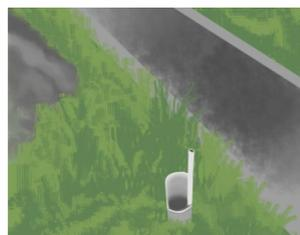
経年変化、雪害等により破損した水閘
