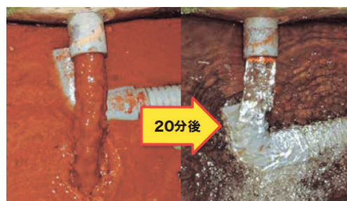
地下かんがいによる暗渠管内の洗浄
