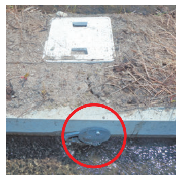
取水口を開けた状態
