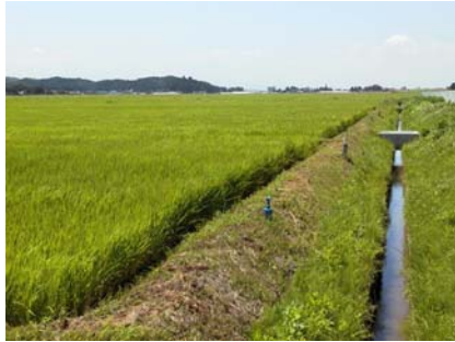
畦畔に露出して設置された従来型水閘
